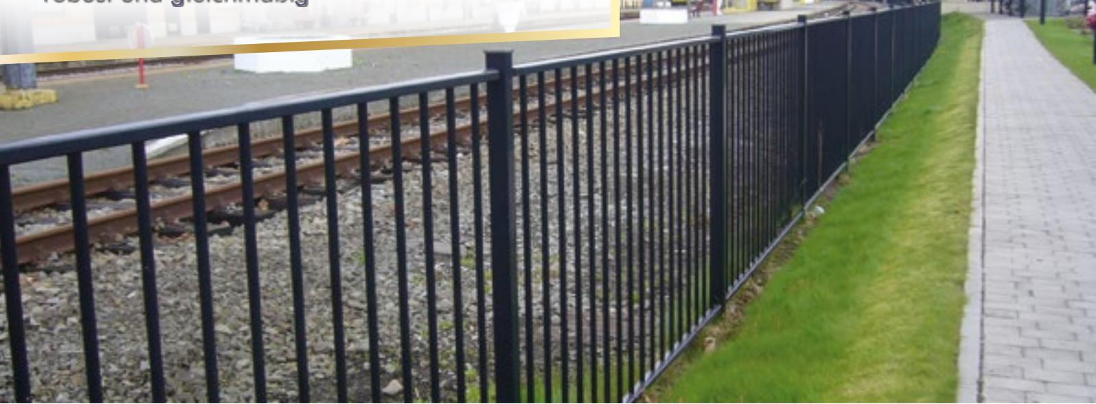
Gitterzaun aus einem stählernen Rahmen mit senkrecht eingeschweißten Stäben. Der Rahmen ist zwischen 2 Pfosten entweder mit Bügelschelle oder einbruchssicher mit Kunststoffklemmstück montiert. Erhältlich in 2 Ausführungen, verzinkt und pulverbeschichtet oder nur feuerverzinkt.
