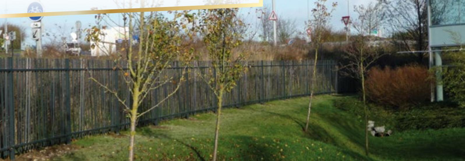
Ein äußerst robustes Stabgitter, gefertigt aus runden Stäben und rechteckigen Profilen. Die Stäbe sind geometrisch ungleichmäßig durch den Ober- und Unterträger geführt. Dadurch lehnt sich das Element an die Optik von natürlich gewachsenen Pflanzen an. Eine verdeckte, einbruchssichere Befestigungsplatte verbindet das Element mit den Pfosten.
